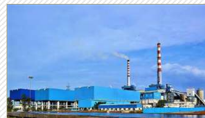
OPG Power Plant - TN
