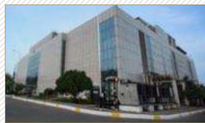
VSNL Data Center - Pune
